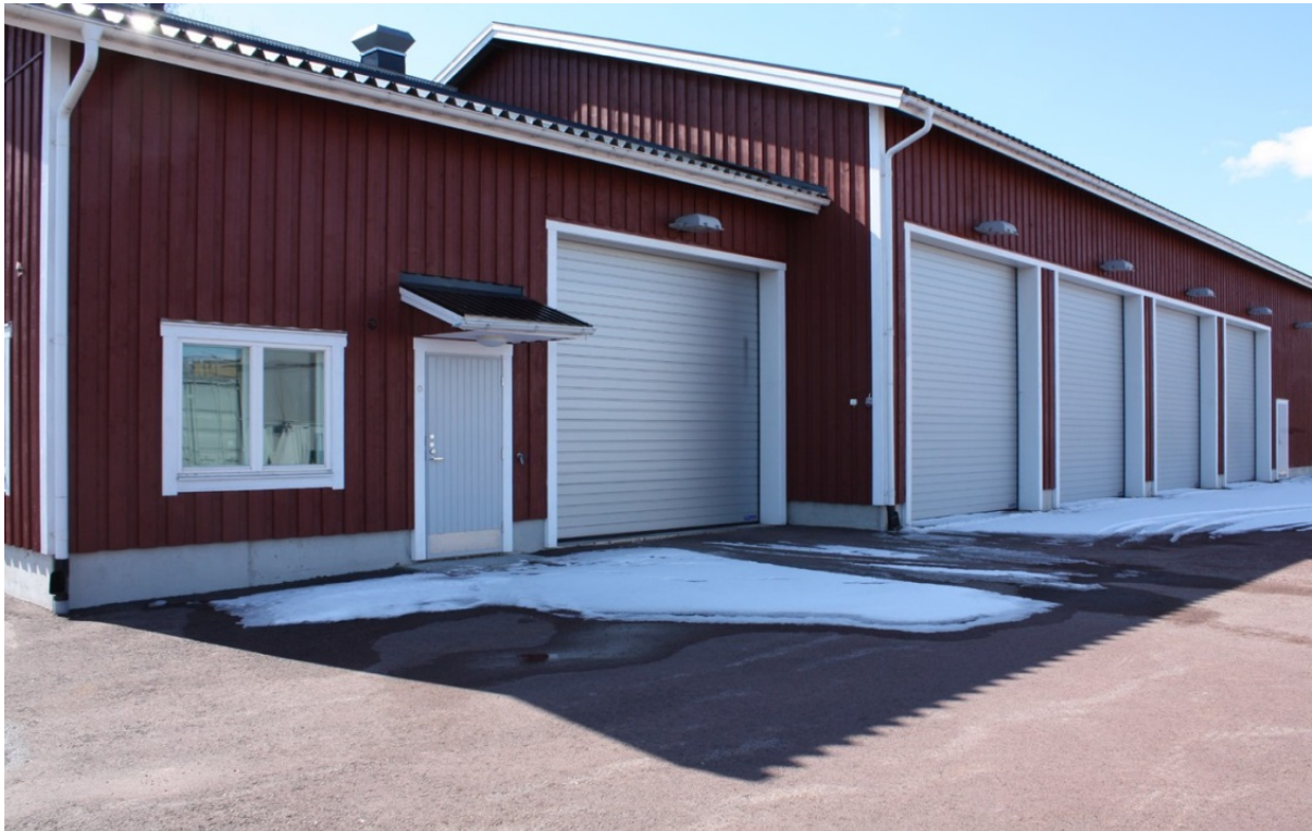
Möckelö oljeskyddslager färdigställdes under våren 2005
