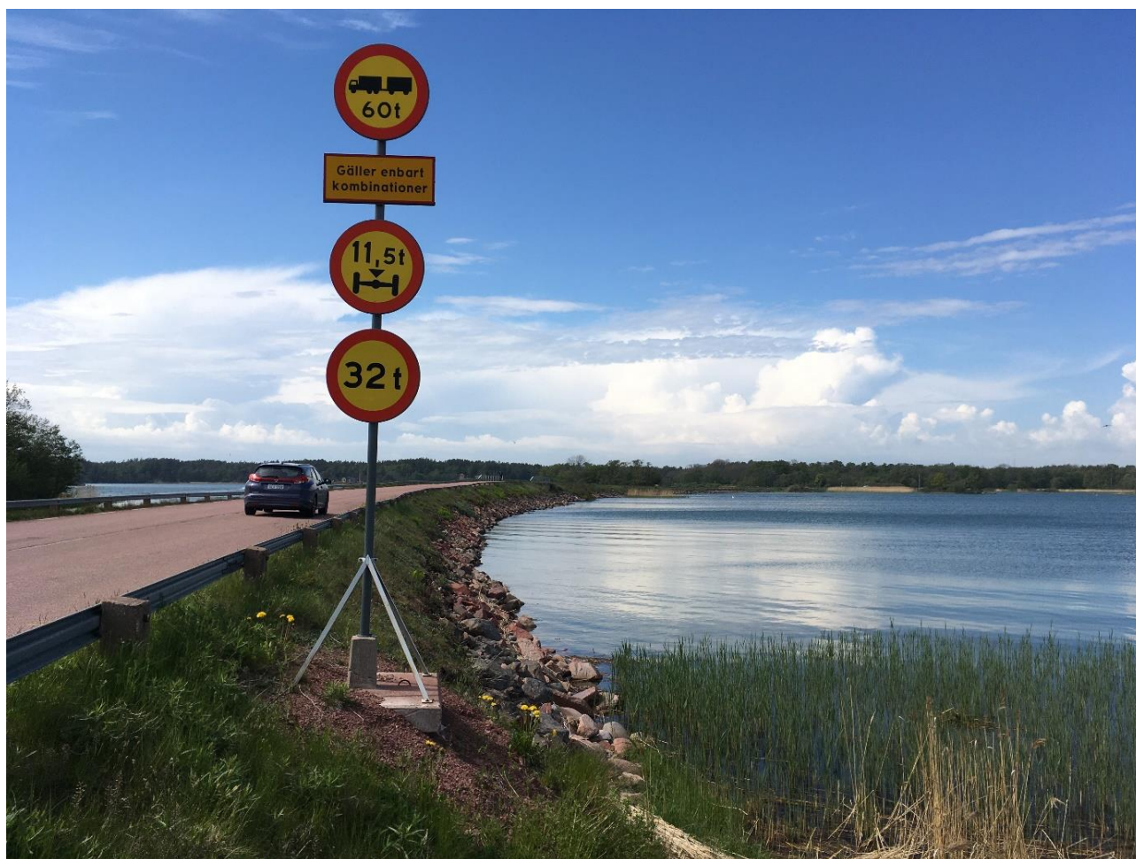
Figur 13. Skyltning av nuvarande viktbegränsningar. Bilden visar Järsöbron i riktning norrut. Fotodatum 2022-06-03
