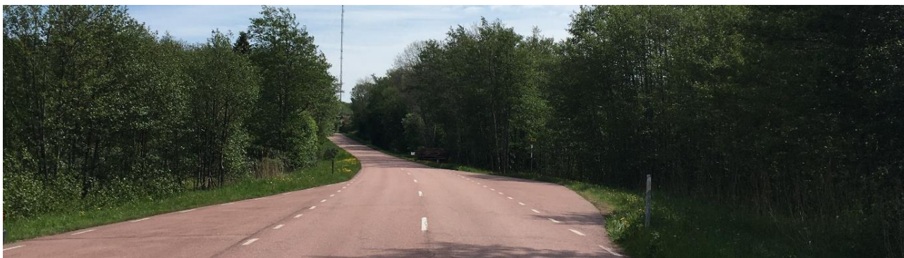
Figur 24. Hållplats Granö. De flesta hållplatser längs sträckan är fickhållplatser utan perrong. Fotodatum 2022-06-30.
