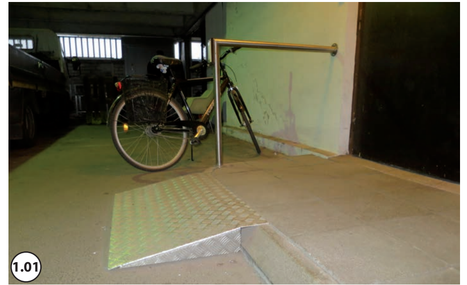
1.01 Ramp saknar avåkningskydd och handledare.
