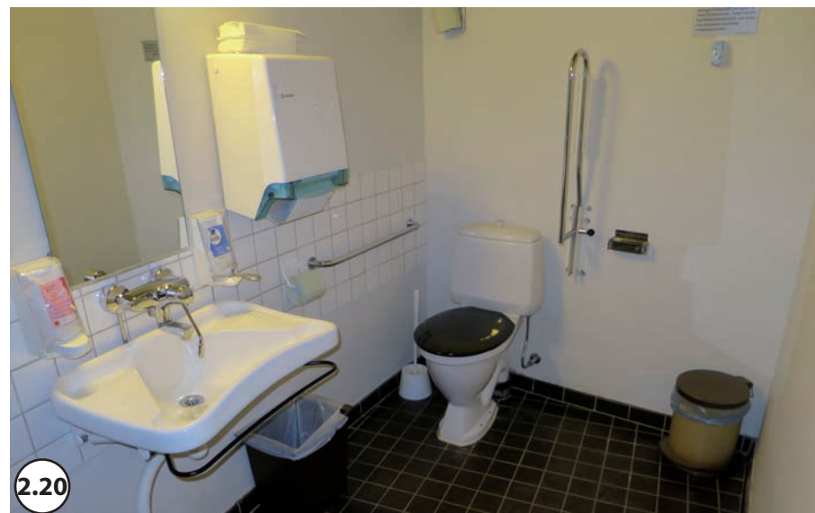
2.20 Inermått och placering av inredning medger sidoöverflyttning från en sida av wc-stolen.
