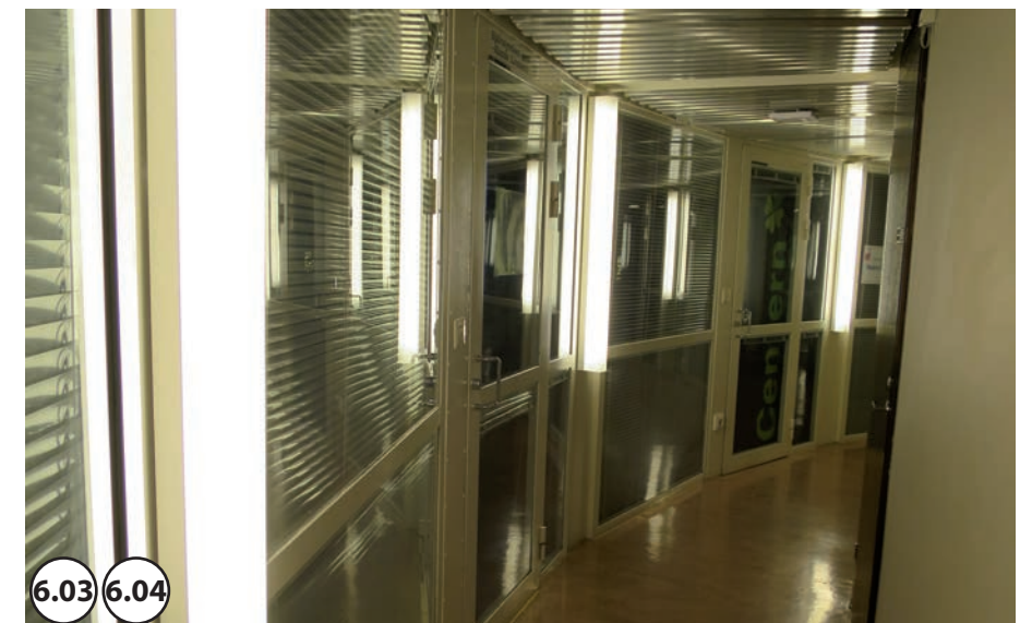
6.03 6.04 Breddmått 1380 mm. Belysningsarmaturer på vägg bländar och reflexer i blankt undertak.
