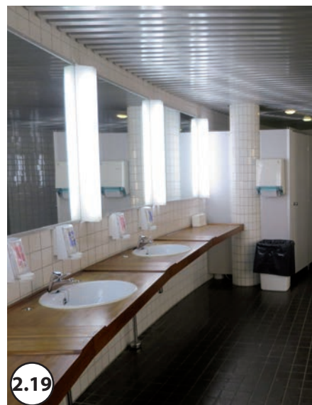
2.19 Belysningsarmaturer mellan speglar bländar något.
