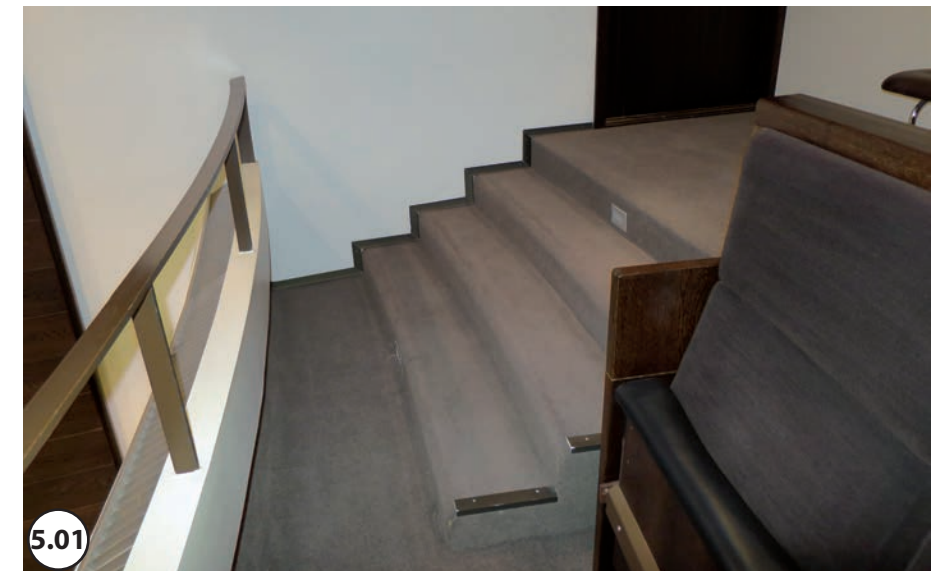
Trappor saknar kontrastmarkering och handledare.
