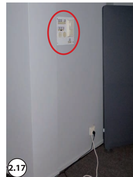
2.17 Ljudanläggningsreglage placerad högt.
