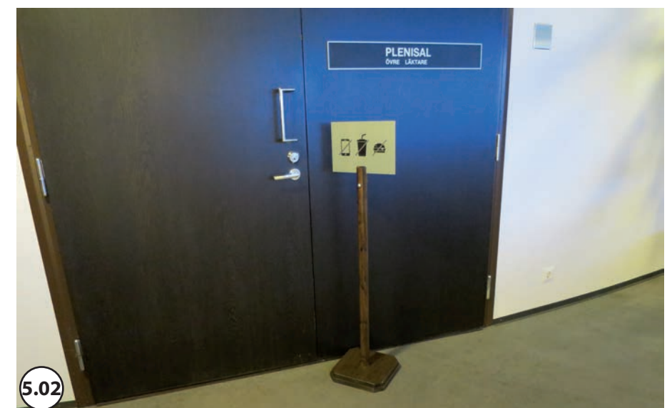
Pardörrar uppställda på magnet. Tröskel något hög.
