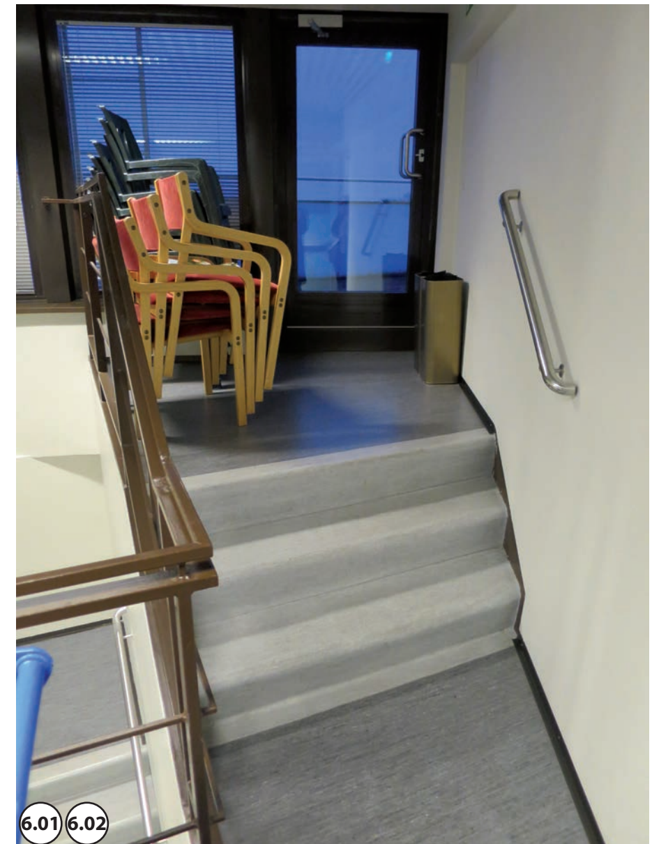
6.01 6.02 Terrass ej tillgänglig. Hög nivåskillnad tröskel terrassdörr. Trappa saknar tydlig kontrastmarkering.
