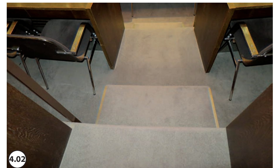
4.02 Mindre trappor saknar kontrastmarkering och handledare.
