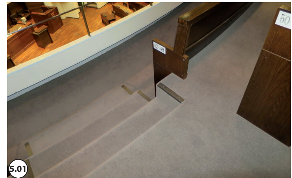
Trappor saknar kontrastmarkering och handledare.
