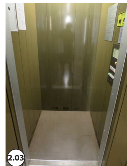
2.03 Korginnermått medger ej plats för person med rullstol och medhjälpare.
