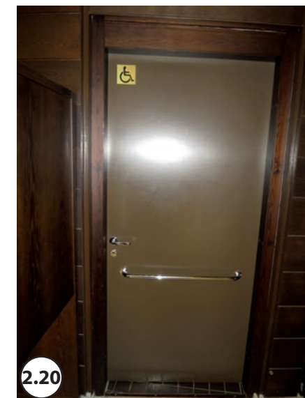
2.20 Skylt placerad på dörrblad. Avviker ej i ljushet mot omgivande väggytor.
