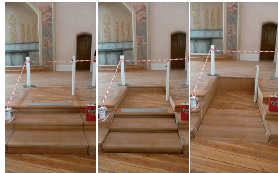
Exempel på lyftanordning från Sofia kyrka.
