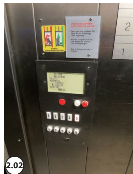
2.02 Hisspanel placerad nära hörn samt saknar relief och punktskrift.
