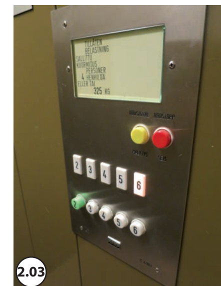
2.03 Hisspanel placerad nära hörn samt saknar relief och punktskrift.
