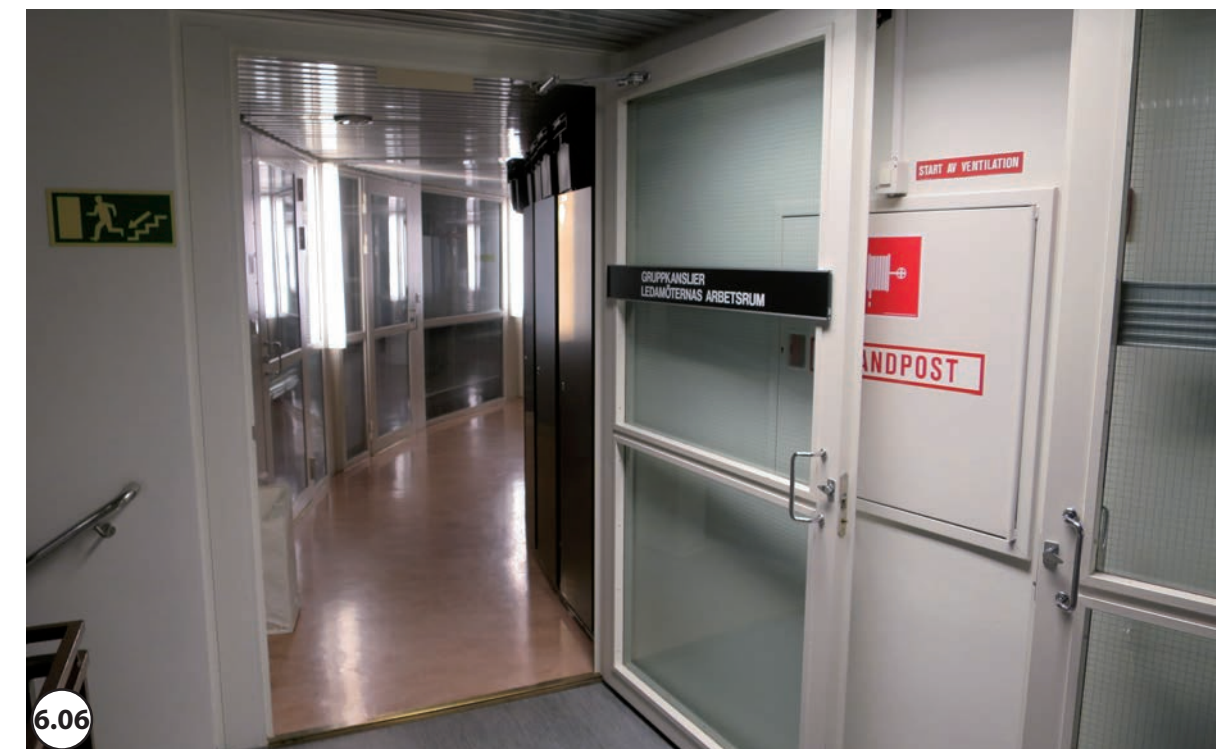
Dörr uppställd på magnet. Dörrförsedd med dörrstängare.
